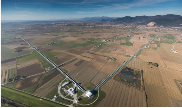
Vue aérienne du détecteur d'ondes gravitationnelles européen Virgo construit près de Pise, en Italie. On distingue le bâtiment central d'où partent les deux bras de 3 kilomètres chacun, les bâtiments d'administration et de recherche.
